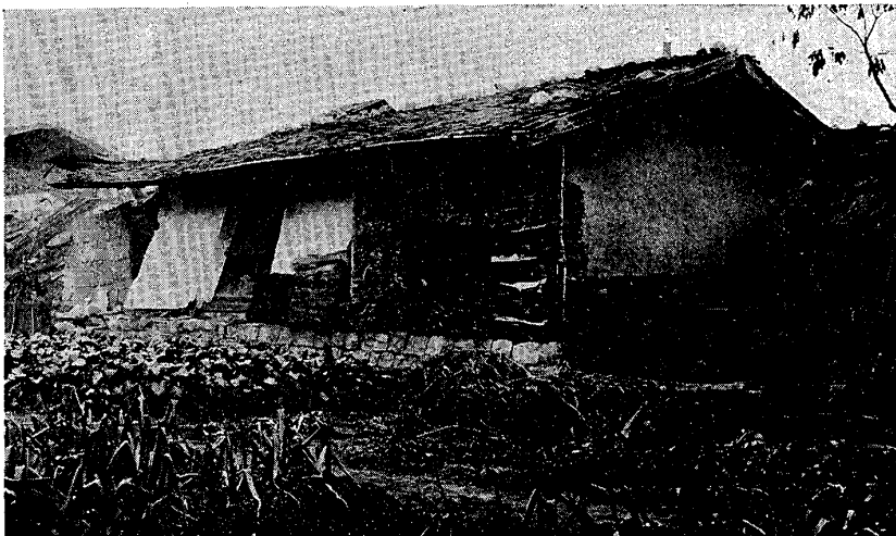
第二圖 大町ノ北端附近ニ於ケル 北ニ傾斜セル建物
