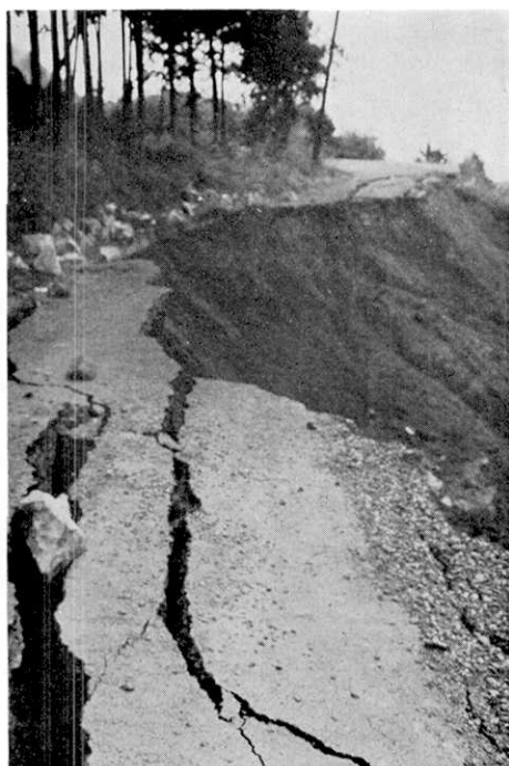
第42図 南熱川，国道沿いの斜面崩壊，頂部
