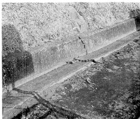
第86図 稲取中学校校庭のコンクリート縁石のきれつ，古いきれつが再び動いている。
