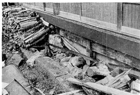
第83図 河津町泉奥原における地割れによる家屋の被害，基礎が右横ずれにくいちがっている。地割れが WNW 方向に続く。
