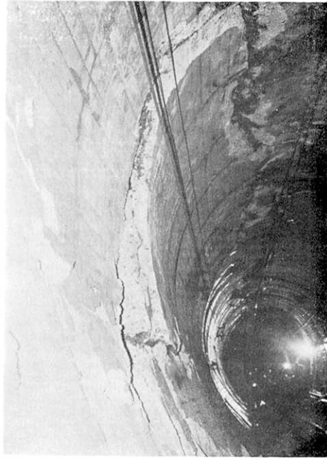
第69図 稲取トンネルの被害，側壁のきれつ
