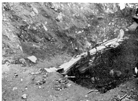
第59図 七滝，斜面崩壊によるバスの埋没
