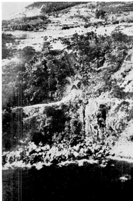
第38図 稲取，旧道ぞいの斜面崩壊
