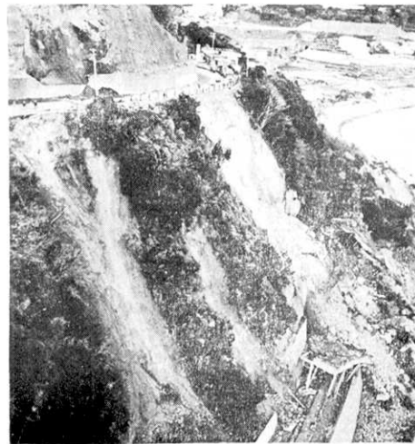
第48図 稲取，斜面崩壊による鉄道シ ェルターの被害
