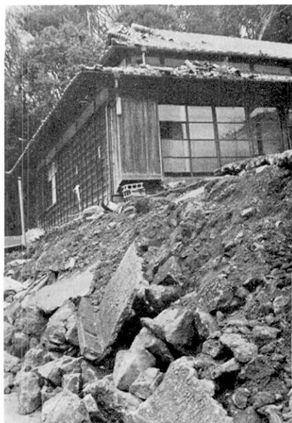
第27図 河津町見高入谷，擁壁の崩壊 による家屋被害
