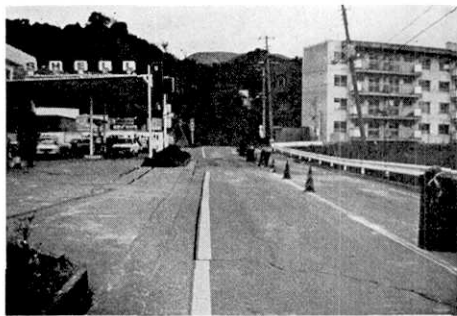
第26図 稲取，土盛り地盤の沈下による 鉄筋コンクリート造建物の傾斜
