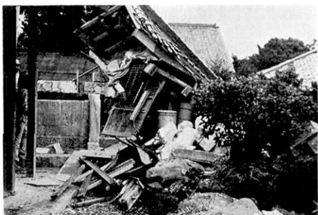
第30図 稲取入谷，断層上の倉庫の倒壊
