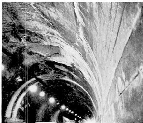
第73図 稲取，国道の黒根トンネルの被害
