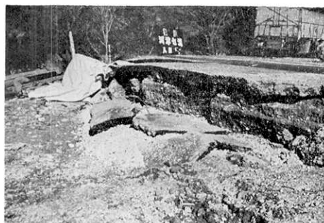
第53図 河津町七滝，道路肩の沈下
