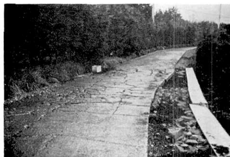
第84図 河津町上佐ヶ野における道路の破損，地割れが WNW 方向に続く。
