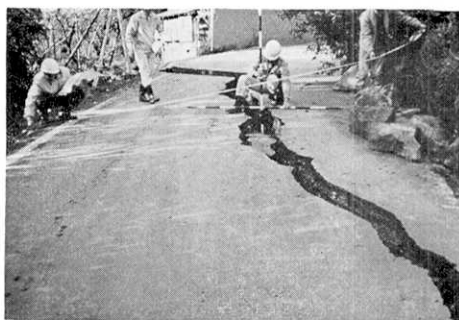
第49図 河津町川横，道路のきれつと沈下
