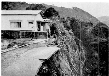
第24図 河津町七滝，河岸の崩落による 家屋被害
