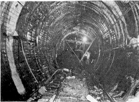
第67図 稲取トンネルの被害，土砂の噴出 (31 k 030 付近)
