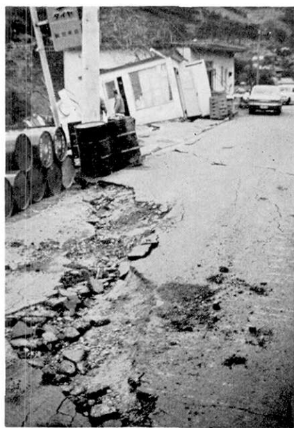
第28図 見高入谷，路肩の沈下に伴う 建物被害
