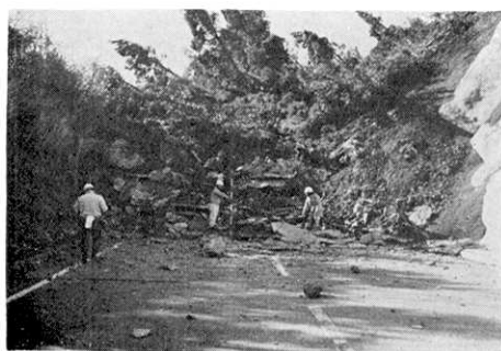
第58図 七滝，斜面崩壊による道路の埋没
