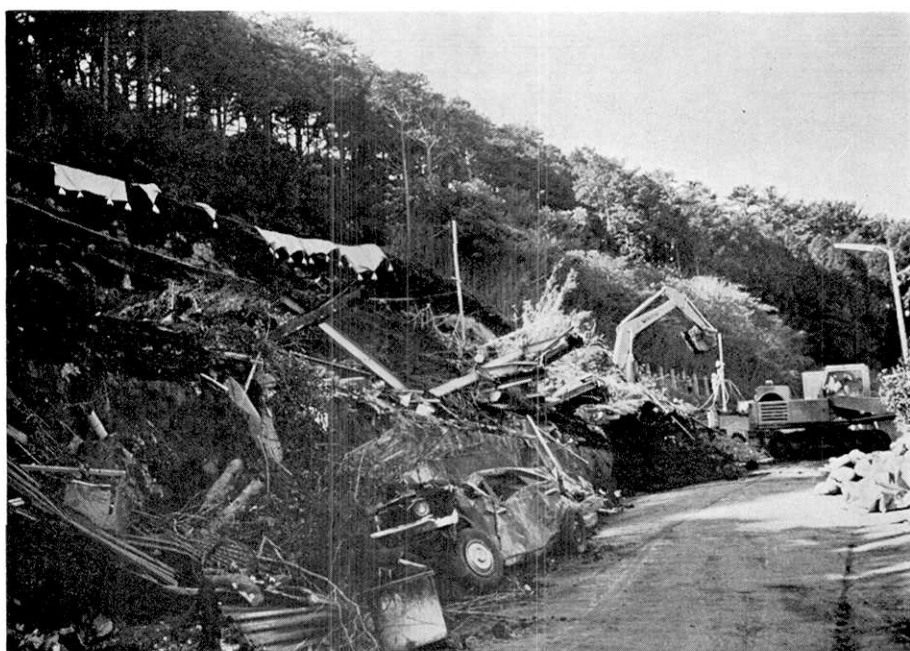
第43図 南熱川，国道沿いの斜面崩壊
