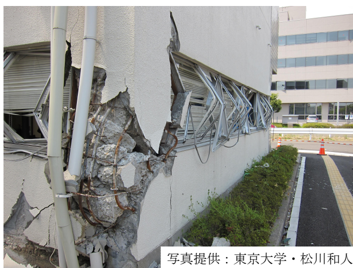
写真 1.2 軸崩壊の被害事例
