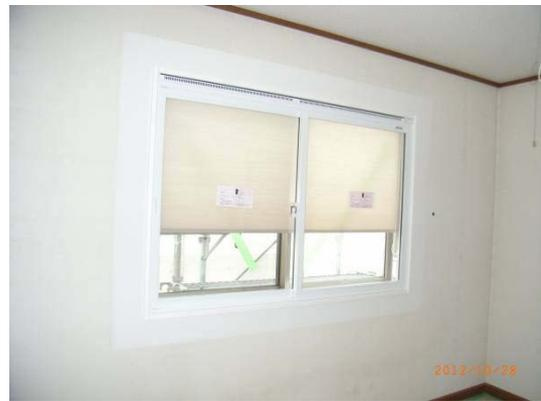
写真-3.3.21 DI窓設置の様子
