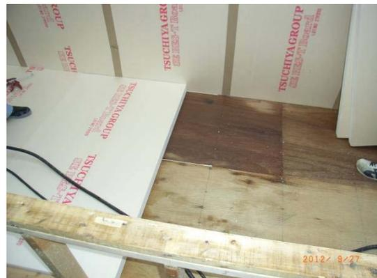
写真-3.3.17 外断熱パネル設置②
