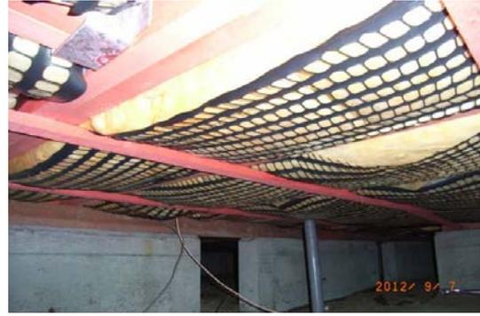
写真-3.3.11 床面の断熱部
