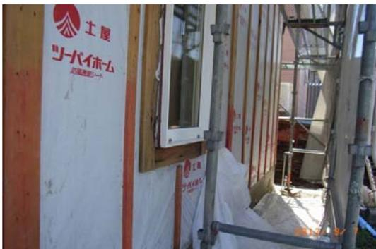
写真-3.3.8 外壁 胴縁部分の気密
