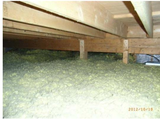
写真-3.3.19 天井の充填断熱
