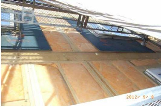
写真-3.3.10 外壁面の充填断熱部
