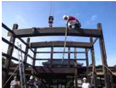
d) クレーンによる梁解体
