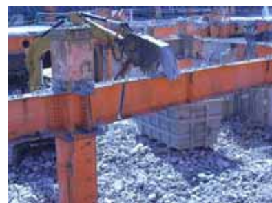
鉄骨躯体解体（鍛冶・鳶工補助）
