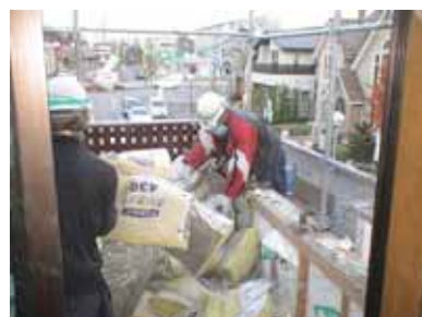
c) 断熱材（グラスウール）積込
