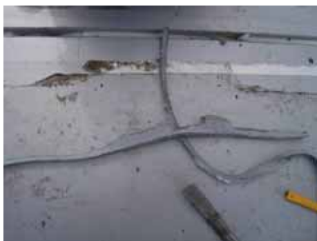
図表 3.2 - 9 漏水箇所の屋根面（左：厚さの不揃いなコーキング材、右：パッキング材のない目地）
