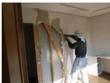
b) 内壁（石膏ボード）解体
