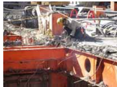
鉄骨梁（内側）溶断
