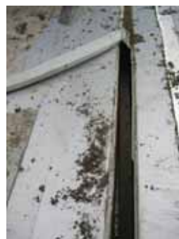
図表 3.2 - 9 漏水箇所の屋根面（左：厚さの不揃いなコーキング材、右：パッキング材のない目地）
