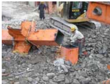
鉄骨柱溶断
