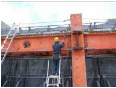
鉄骨梁（外周）溶断
