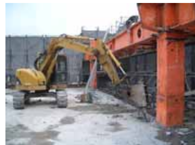
スラブ端破碎・削孔
