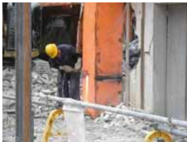
鉄骨柱溶断
