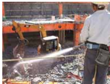
破碎に散水する解体工（重機補助作業者）
