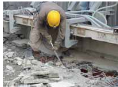
床スラブ鉄筋溶断
