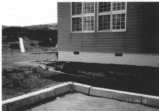
(a) 中ノ沢小学校校舎周辺の地盤の沈下状況
