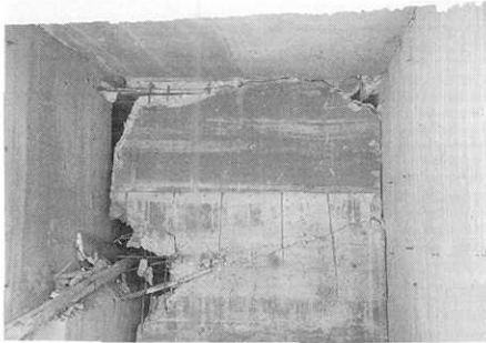
写真38 エキスパンション・ジョイント近傍の基礎つなぎ梁のせん断破壊
