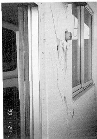
写真27 外壁 ALC 板の損傷
