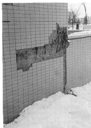
写真42 1 階南西隅角部の破損
