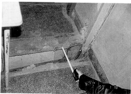
写真4 南棟と正面棟のエクステンションジョイントの開き
