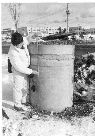
写真49 約150cm浮上したマンホール
