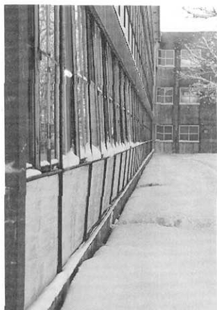
写真9 1号校舎1階北側廊下の腰壁CBの外倒
