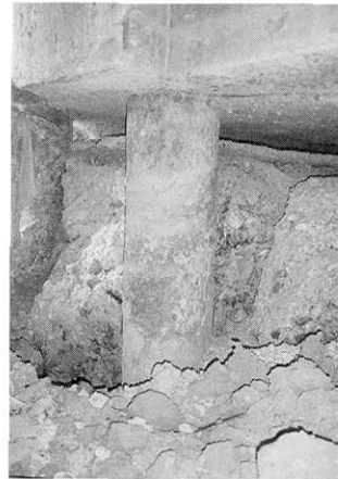
写真39 基礎杭の露出
