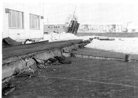
写真20 荷さばき場周辺地盤の不同沈下（相対的に高い部分は護岸の反力用ブロック）
