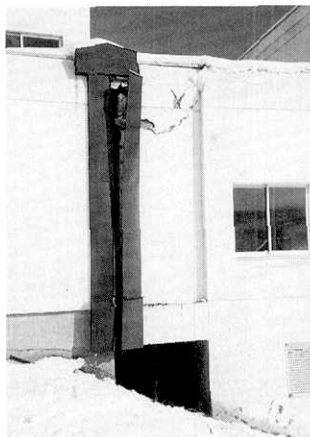
写真36 エキスパンション・ジョイント周りの破損
