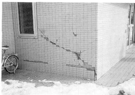
写真41 南口西面壁のせん断ひび割れ
