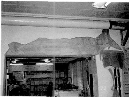
写真30 RC部仕上モルタルの落下
