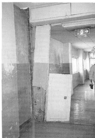
写真13 3号校舎3階化学反応実習室前の防火扉の被害
