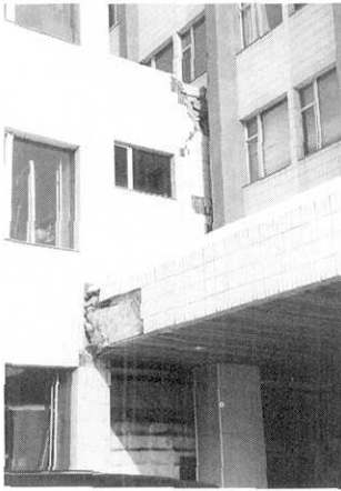
写真22 人文・管理棟-教室棟，玄関棟のつながり部の破損
