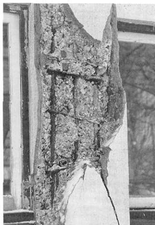
写真12 2号校舎1階西側廊下外柱のせん断破壊
