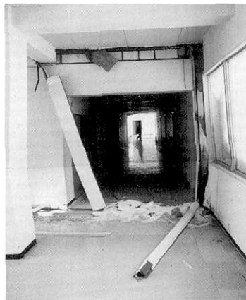
写真37 2階エキスパンション・ジョイント周りの破損
