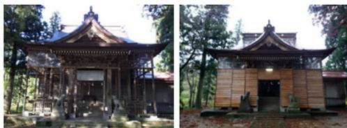
図 骨組みの状態の雪囲い 図 設置された雪囲い (撮影者 日高仁)
