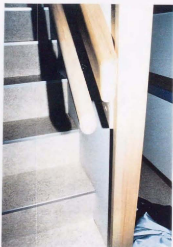
写真2 握れない板状の手すり(上), 下の手すりは改善後
