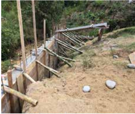
図 2-4-14. 竹を使った型枠支柱
