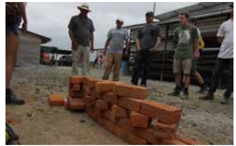
図 3-3-9. レンガの積み方のスタディ
