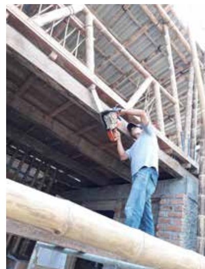
図 4-4-10. 根太を切るファビアン
