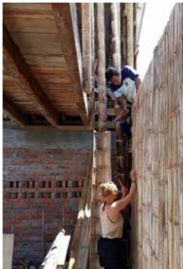
図4-4-11. 土壁の下地を施工する住民と学生
