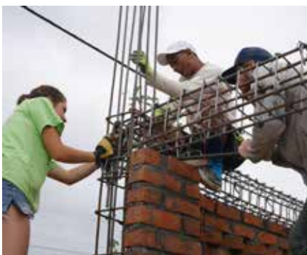
図 4-4-7. 鉄筋を組む学生と地元の大工
