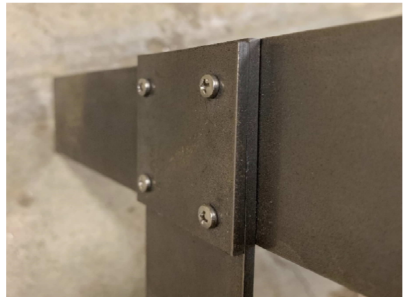
図 3-13 柱1 柱頭の固定
