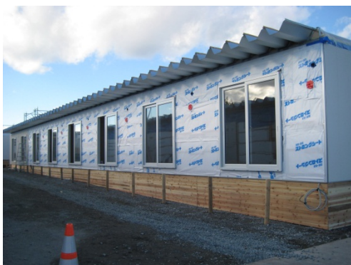
図 5-116. 新たな防水シートが張られた壁面 (SY 社)
