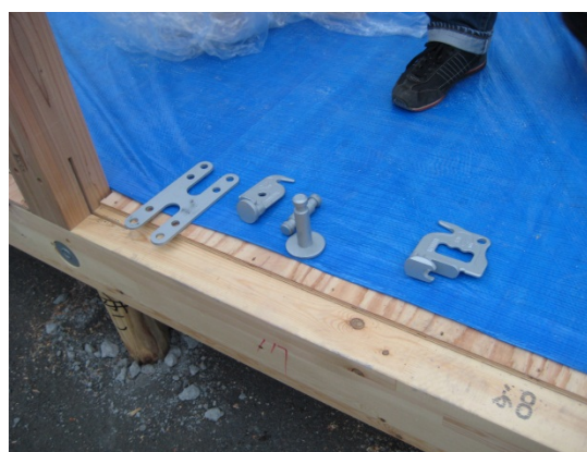
図 5-15. FF 社が採用した構法で使用する接合金物
