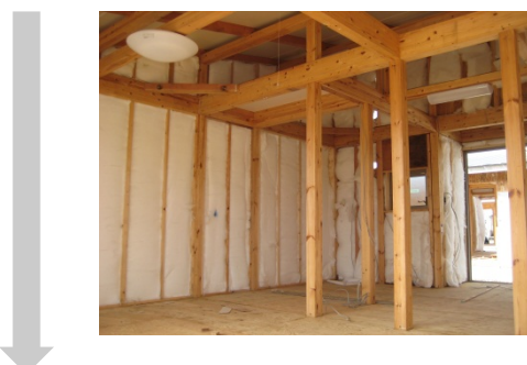
図 5-36. 間仕切り材・界壁材取り付け作業中の住棟
