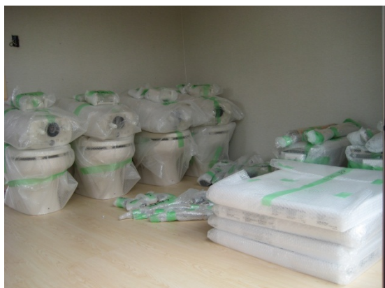
図 5-83. 気泡緩衝材で包んだ設備機器 (A社) 図 5-84. 養生テープで保護した建具(A社)
