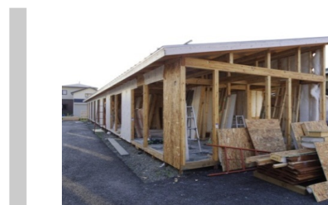
図 5-23. 壁下地材を取り外している住棟
