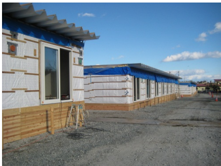
図 5-89. SY 社の躯体(壁パネル)の組み立て後
