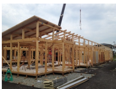
図 5-25. 天井パネルを取り外している住棟
