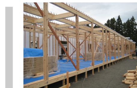
図 5-54. 躯体の組み立てが終わった住棟
