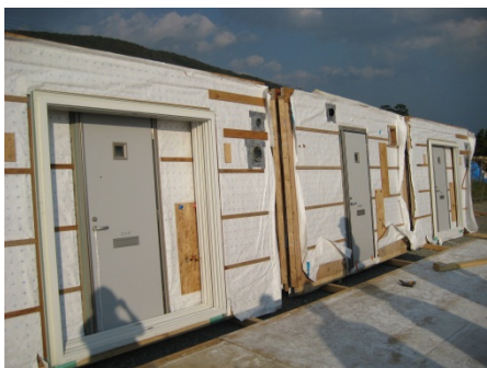
図 5-69. SY 社が建具の枠や玄関扉を残した状態で取り外した壁パネル
