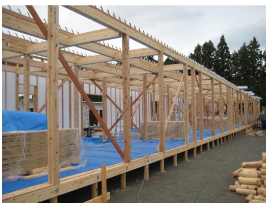
図 5-14. FF 社が建設した応急仮設住宅の躯体
