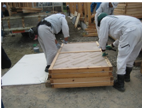
図 5-99. 汚れや傷がある天井パネルの化粧合板を交換している様子 (A 社)
