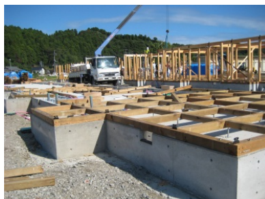
図 5-31. 土台の設置が完了した住棟
