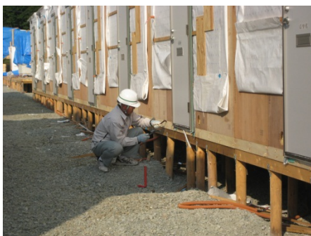
図 5-75. SY 社が深く打ち込まれた釘を引き抜いている様子
