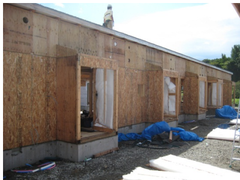
図 5-111. 壁下地パネルの取り付け後の様子（A社）
