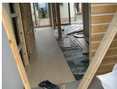
図 5-21. 仕上げ材を一部取り外した床
