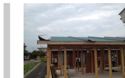
図 5-24. 屋根材を取り外している住棟
