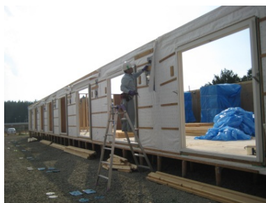
図 5-44. 取り外す前の壁パネル
