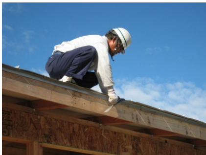
図 5-94. 新たな位置で金属板を折り曲げる様子 (A 社) 図 5-95. 余分な金属板を切断する様子 (A 社)
