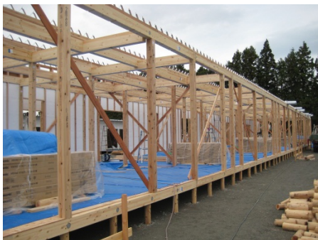
図 5-92. NC 社の躯体(柱・梁)の組み立て後
