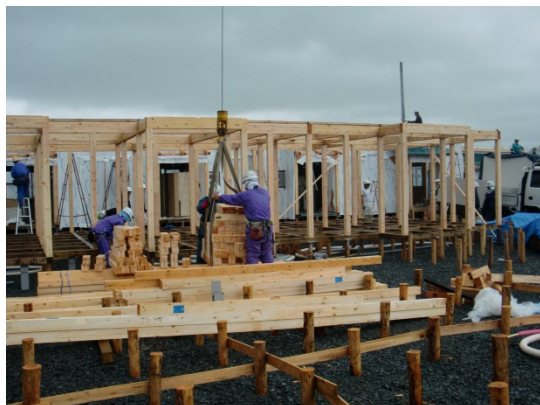
図 5-10. A 社が建設した応急仮設住宅の躯体
