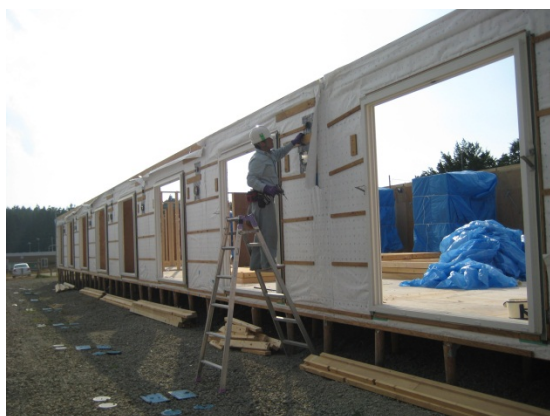
図 5-12. M 社が建設した応急仮設住宅の躯体
