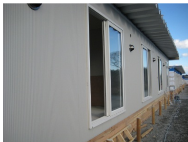
図 5-49. 外装材・建具取り付け後の住棟
