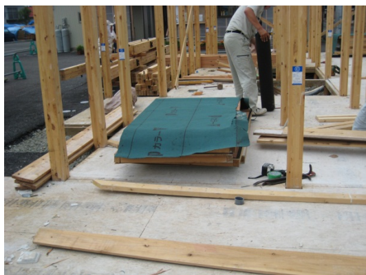
図 5-85. 廃棄予定の防水シートで包んだ解体部材 (A社)
