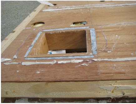
図 5-76. SY 社が解体した壁パネルの接着剤の使用跡
