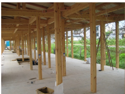
図 5-72. ユニットバスを撤去した状態の A 社の解体現場
