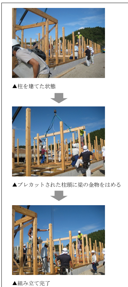
図 5-88. A社の躯体(柱・梁)の組み立て方
