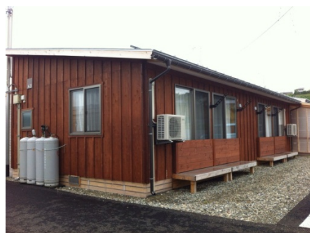
図 5-126. 雪止め板が設置された移築前の住棟 (A 社) 図 5-127. 雪止め板を再利用して作られた縁台 (A 社)
