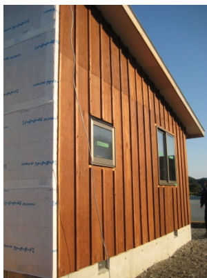
図 5-38. 外装材を取り付けた住棟
