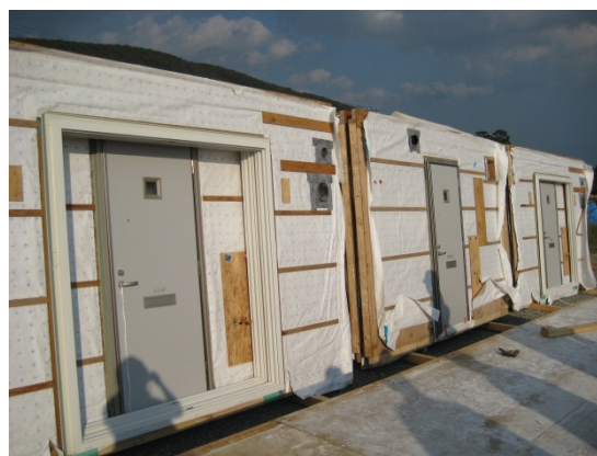
図 5-13. M 社が建設した応急仮設住宅の壁パネル
