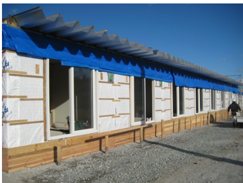
図 5-115. 防水シートを剥がさずに移築した壁パネル (SY 社)
