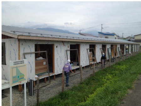
図 5-67. A 社が取り外した建具の枠
