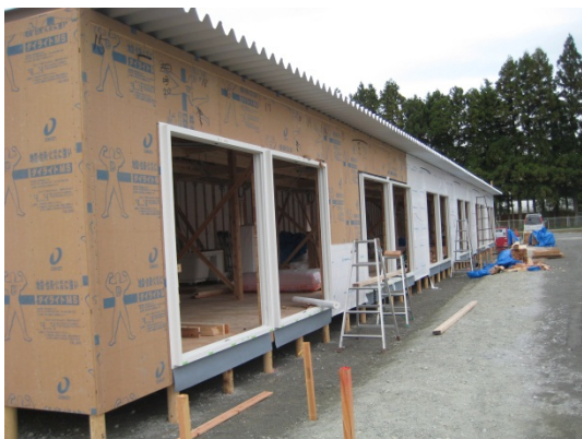
図 5-98. 折板屋根設置後の様子 (NC 社)
