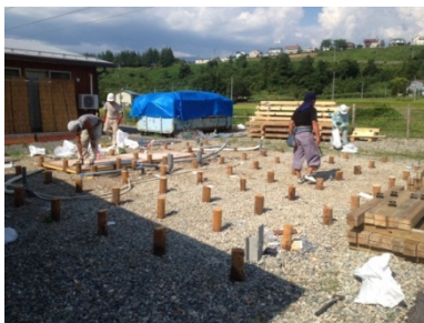
図 5-29. 床下地材と土台を取り外した住棟
