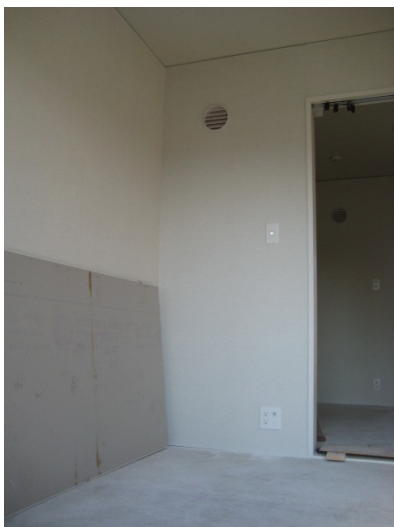
図 5-103. 新たな化粧石膏ボードを張った仕上げた内壁(SY 社)
