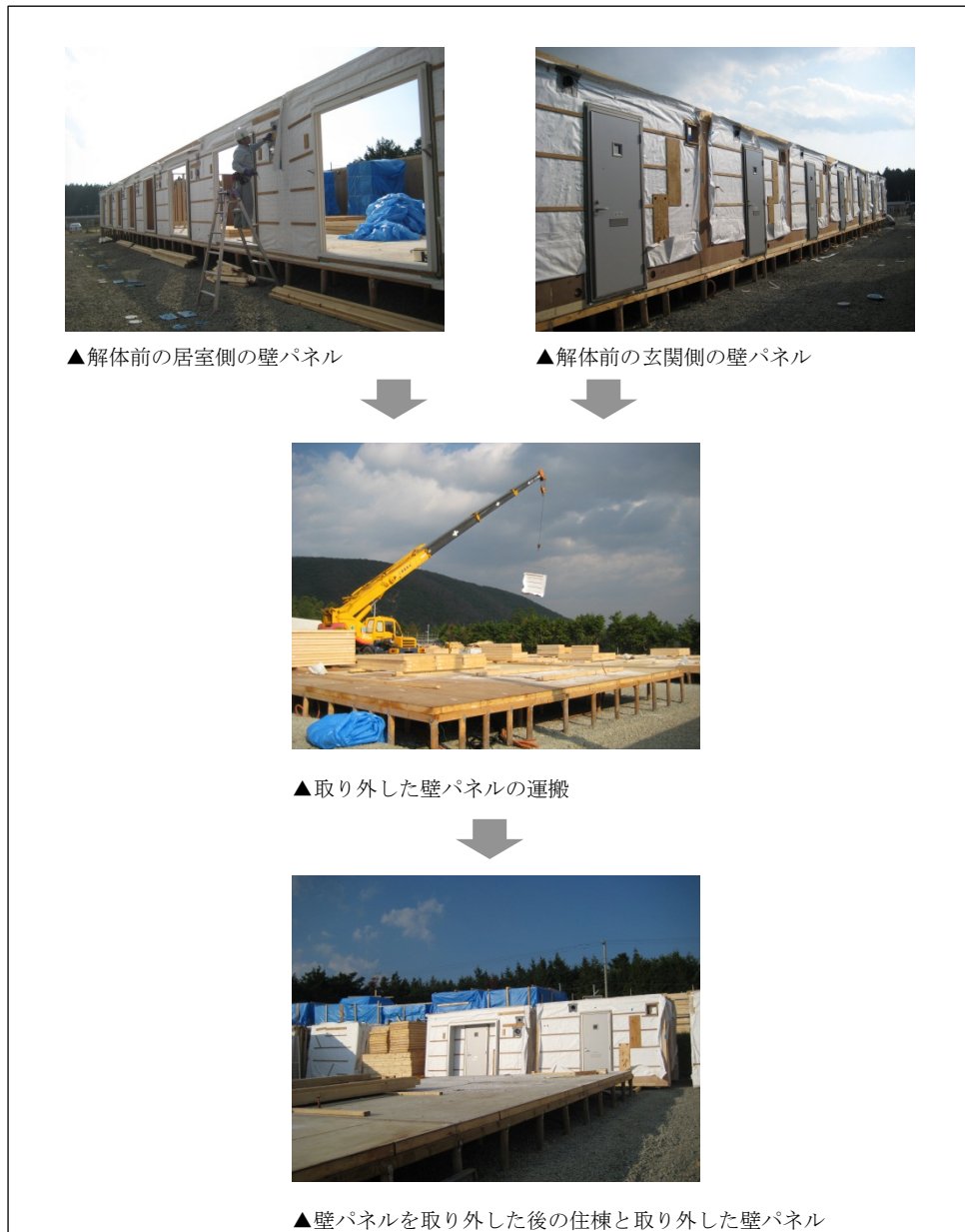
図 5-61. SY 社の躯体(壁パネル)の解体方法
