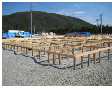
図 5-46. 床下地材を撤去した住棟
