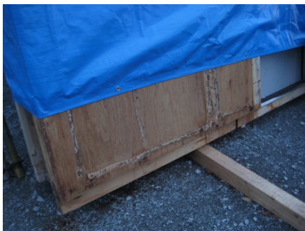
図 5-91. 接着剤の跡が残った壁パネル(SY 社)
