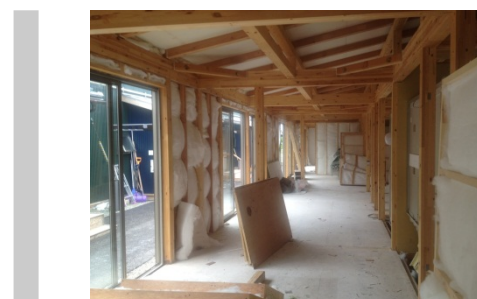
図 5-22. 間仕切り・界壁を取り外した住棟
