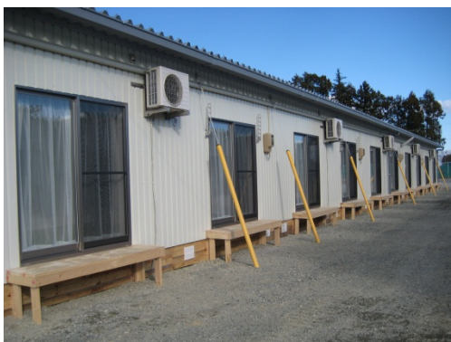
図 5-120. 新たに調達した掃出し窓が取り付けられた住棟 (NC 社)
