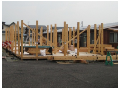
図 5-26. 梁を取り外した住棟
