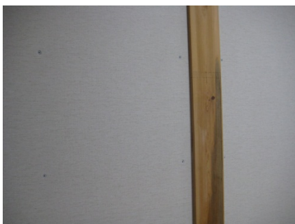
図 5-102. 新たな化粧石膏ボードを張った仕上げた内壁(A 社)
