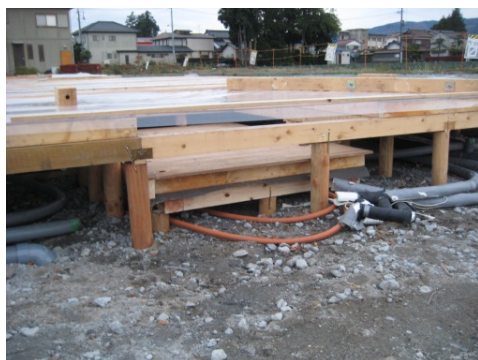
図 5-112. ユニットバス設置部分用に下げた土台と木杭（SY社）
