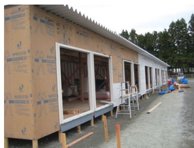
図 5-55. 壁下地・建具の枠を取り付けた住棟
