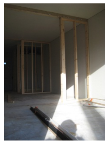
図 5-50. 内装材・間仕切り取り付け作業中の住棟
