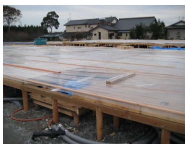
図 5-48. 床下地材の取り付け後の住棟
