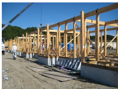
図 5-32. 柱・梁の組み立て作業中の住棟
