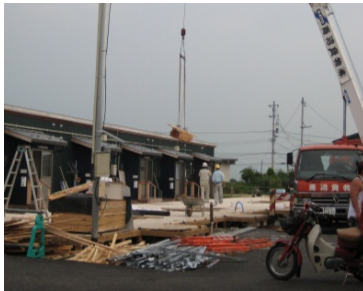
図 5-27. 柱を取り外した住棟
