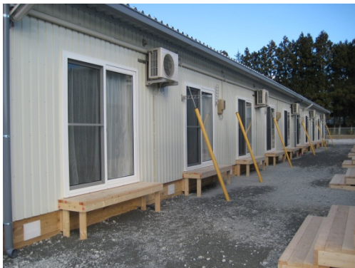
図 5-119. リユースした掃出し窓が取り付けられた住棟 (NC 社)
