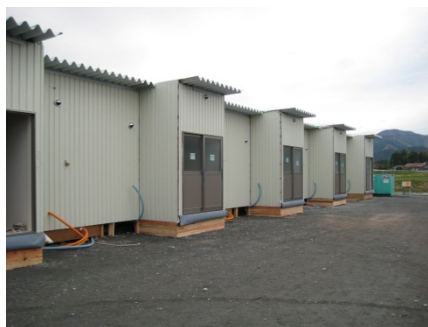
図 5-57. 外部建具を取り付けた住棟
