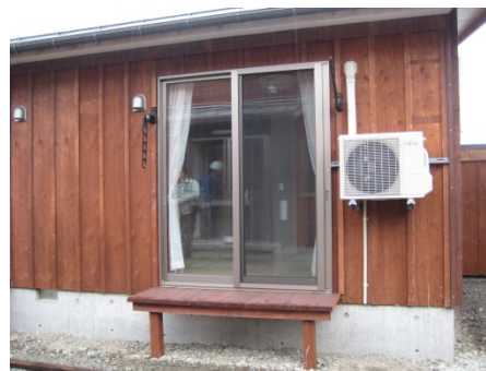
図 5-126. 雪止め板が設置された移築前の住棟 (A 社) 図 5-127. 雪止め板を再利用して作られた縁台 (A 社)
