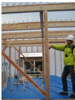
図 5-93. 柱心をずらして組み立てた柱(NC 社)
