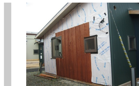
図 5-20. 仕上げ材を一部取り外した外壁
