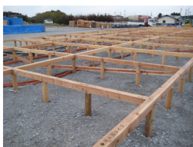
図 5-47. 木杭・土台取り付け後の住棟
