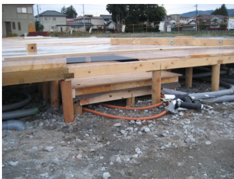
図 5-121. ユニットバス設置部分用に下げた土台と木杭 (SY 社)
