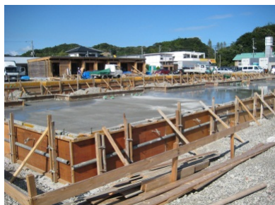
図 5-30. コンクリートを打設している住棟
