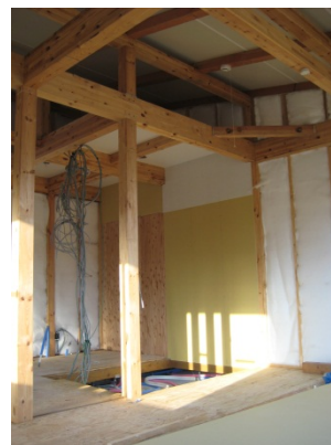
図 5-39. 内装材を取り付け中の住棟
