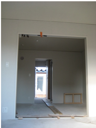
図 5-101. 新たな化粧石膏ボードを張った仕上げた天井(SY 社)
