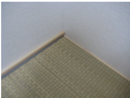
図 5-104. 畳と内壁の隙間を埋める木材(A 社)
