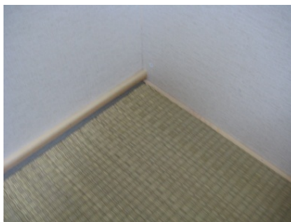
図 5-124. 畳と内壁の隙間を埋める木材(A社)
