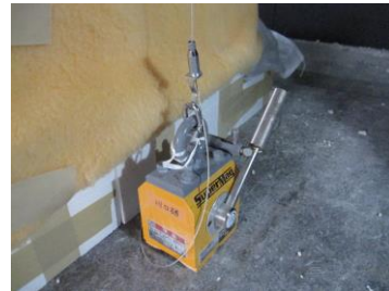
図 2.14 ホイスト及びガイドワイヤーの設置状況
