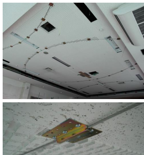
図 C. 1.5.7 ケーブル，金具設置
