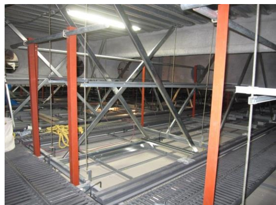
(d) 天井の耐震・制震化
