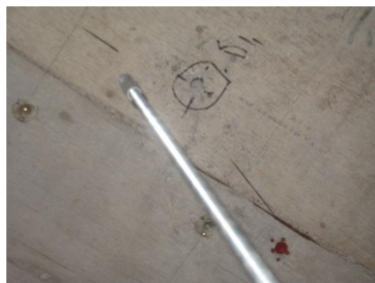
(d) 吊りボルトの脱落
