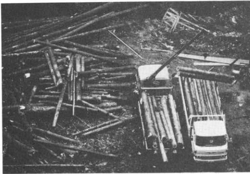
図-3 ウィンチクレーンによる木材積込作業 (1980年12月 東京大学千葉演習林)
