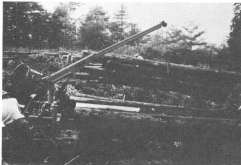
図-10 小型ウィンチクレーンによる林内作業車 への木材積込作業 (1982年8月 群馬 県下仁田町)
