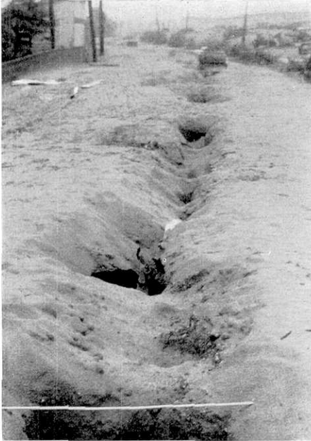
第6図 新潟市川岸町附近 下水道に沿つた地下水および砂の噴出の跡。
