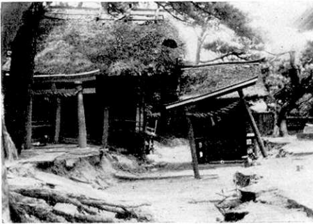
第8図 神林村塩谷 塩竈神社境内における陥没。
