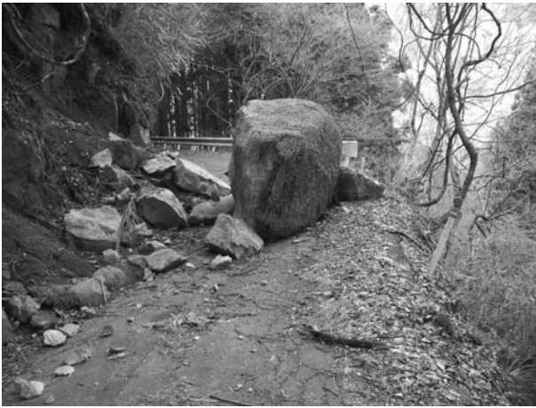
図 5. 落石でふさがれた道路 (いわき市田人町)
