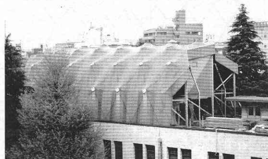
写真1 張力安定トラスドーム：全体モデル(膜あり)
