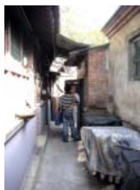
写真 5-2 東四地区住宅の内部
