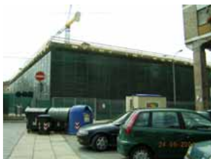
写真 4-13 : 建て直し中の衣料品部門の建物
