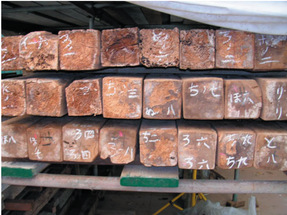
写真 3.2.8 ストック状況（図面に従い同じ位置に柱・梁をリユースする）
