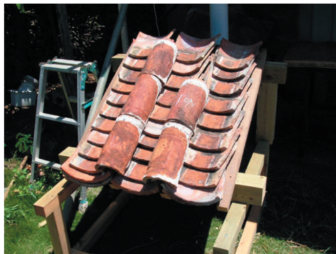
写真 3.2.2 解体された石垣島の民家から取り出した伝統的な赤瓦
