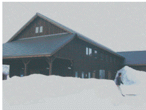
写真 3.4.2 砂川市のアップルガーデン (旧滝川畜産試験場機械庫の古材をリユース) 2002 年建設 木造一部 2 階建 延床面積 364 m 2
