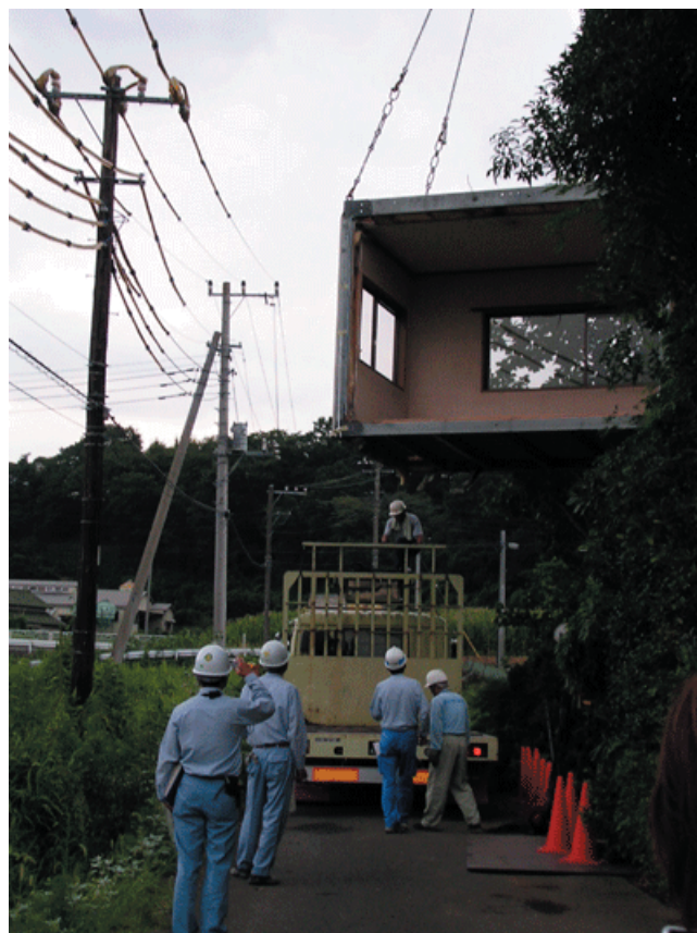
図 3.5.1-2 ユニットの解体と運搬
