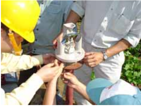
図 5 自記雨量計設置の様子
