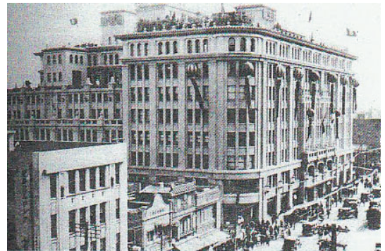
1933年の竣工時 中央通り北側より
