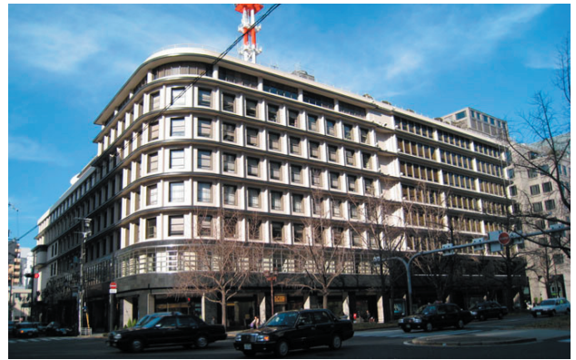
御堂筋側から見た東側外観
