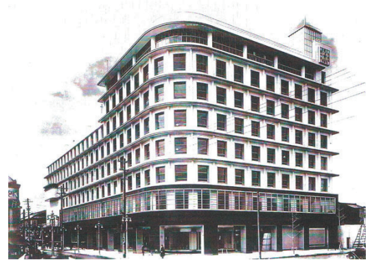
1933 年 竣工当時の外観
