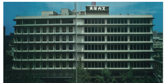
1966 年 竣工当時の東側外観
