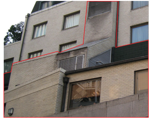
赤枠内が増築部分 外装材の連続
