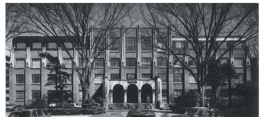
増築後の西側正面
