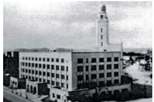
1934 年完成の既存建物
