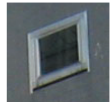
高層棟の開口部
