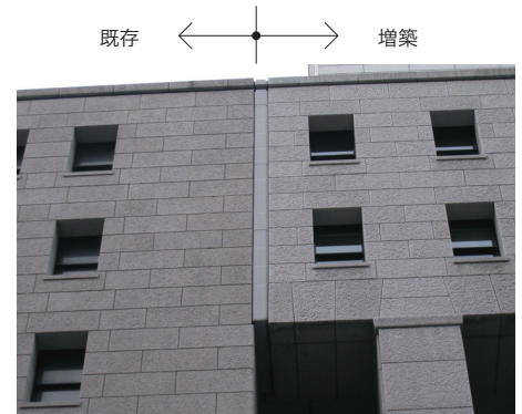
南側立面 新旧の接続部分 既存立面の高さ・開口部・外装が連続
