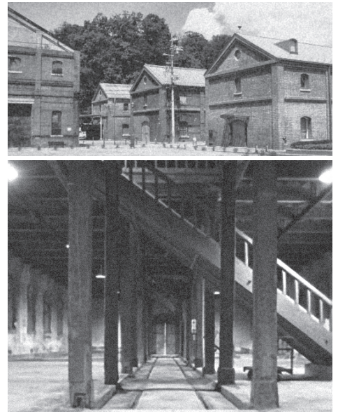
fig4.3.3 舞鶴倉庫群外観，倉庫内観
