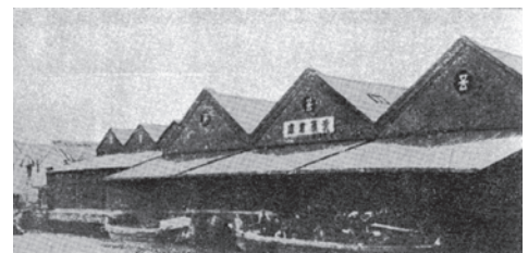
fig4.2.11 澁澤倉庫南茅場河岸倉庫 『澁沢倉庫六十年史』澁沢倉庫六十年史編纂委員会編 P.25
