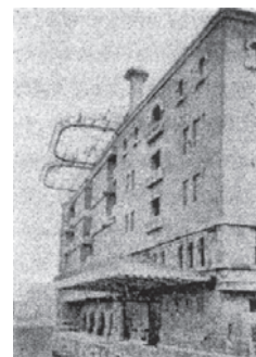
fig4.2.14 三菱江戸橋倉庫 『新版日本倉庫業史』日本倉庫協会編纂 p.53
