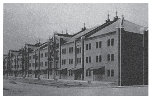
fig4.3.5 横浜新港埠頭保税倉庫外観
