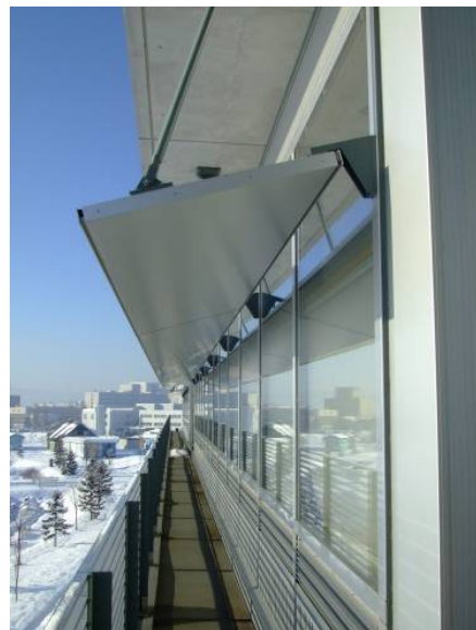
南南西面ライトシェルフと庇
