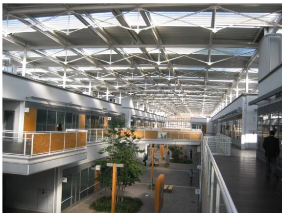
半屋外アトリウム ※ PV とポリカーボネート（半透明）が縞状の光に満ちた空間を創り出している。 ※ 軽快なトラスは綿密な構造解析でつくられた。
