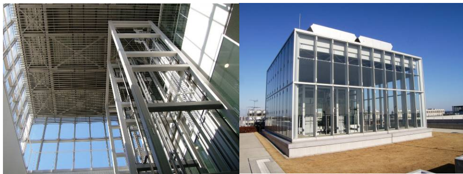
アトリウムと 排気ベンチレーター
