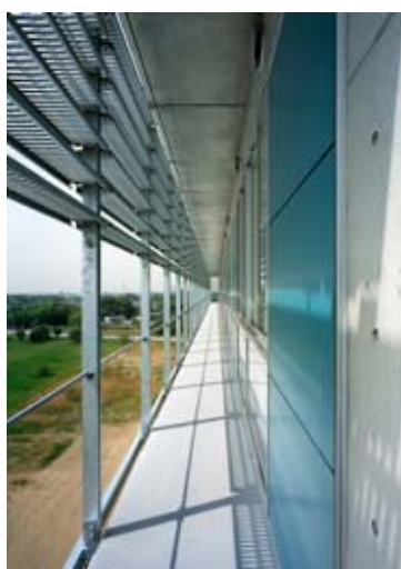
南面ルーバーと 庇(緊急避難路)
