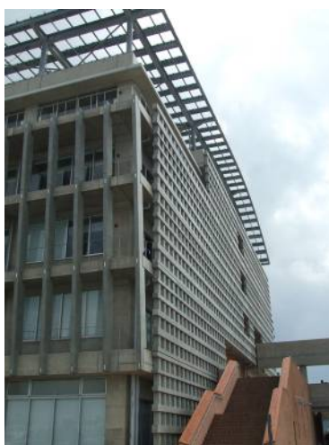
北面ルーバーと花ブロック、 屋上 PV シェルター
