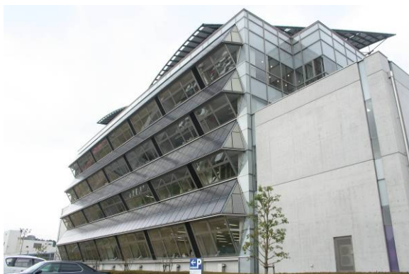
傾斜窓とPV傾斜庇
