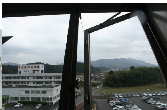
傾斜窓と開閉方式
