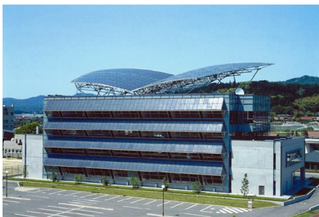
左写真：屋上PVとPV傾斜庇
