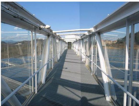
展望ブリッジから太陽光発電（400kW）を望む ※ 身体スケールで体感することができる。
