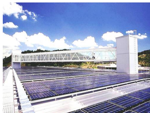
屋上のPV展望ブリッジ
