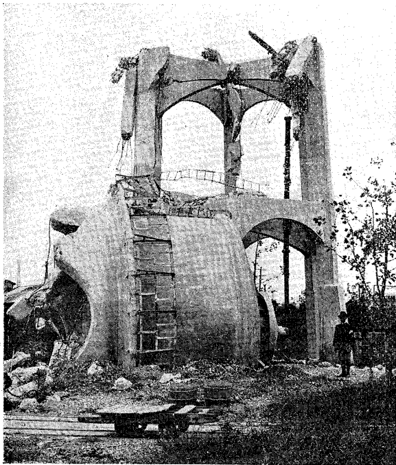
第十五 三河島汚水處分場高置 (全景) 水槽震害狀況
