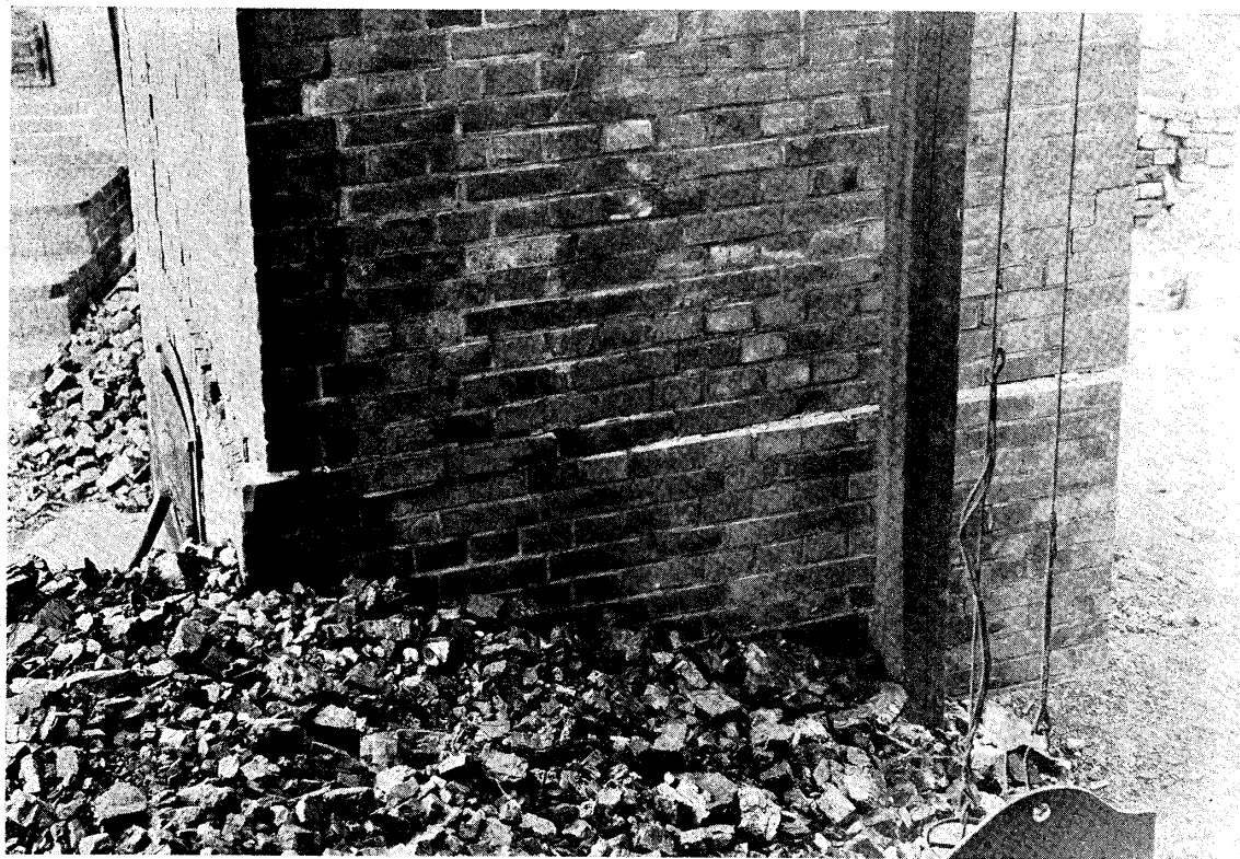
第三 西ヶ原農事試験場煉瓦煙突頂部ノ被害
