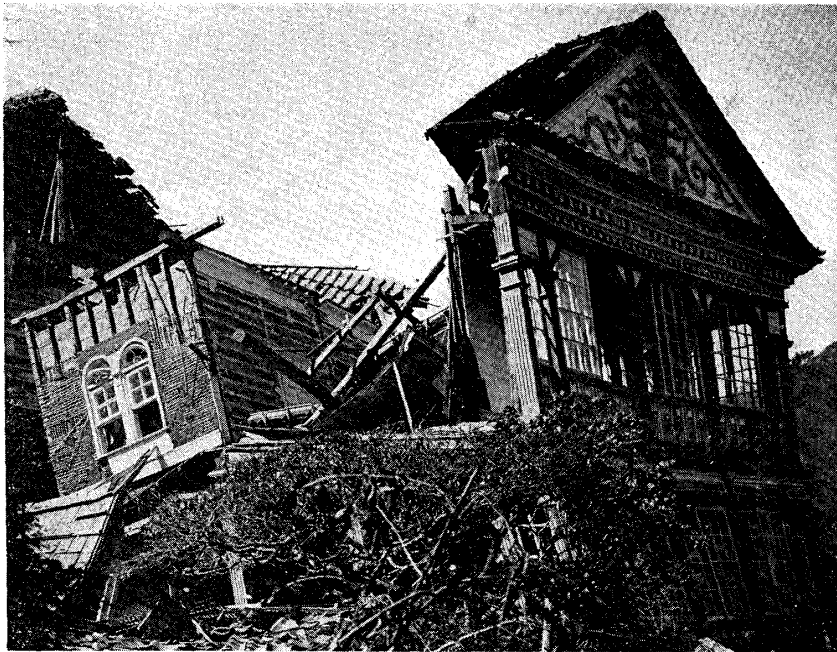
第二十五 奈良屋ホテルノ震害
