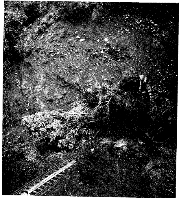
第三十第 箱根登山鐵道仙人臺西ノ震害
