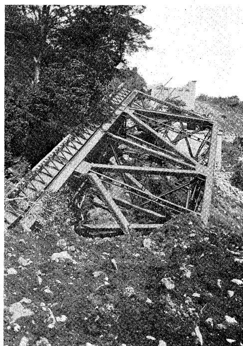
第五十六 熱海線白糸川橋梁ノ墜落セル百五十呎上路構桁 (其ノ泥流中ニ埋没セル狀況)
