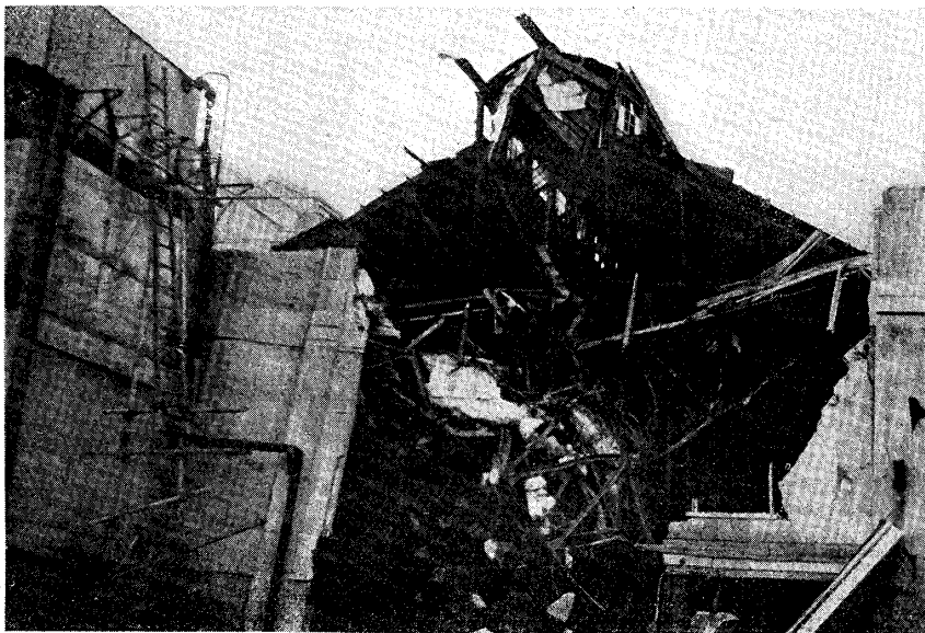
第三圖 隅田發電所ノ煙突ノ倒潰及建物ノ破壊
