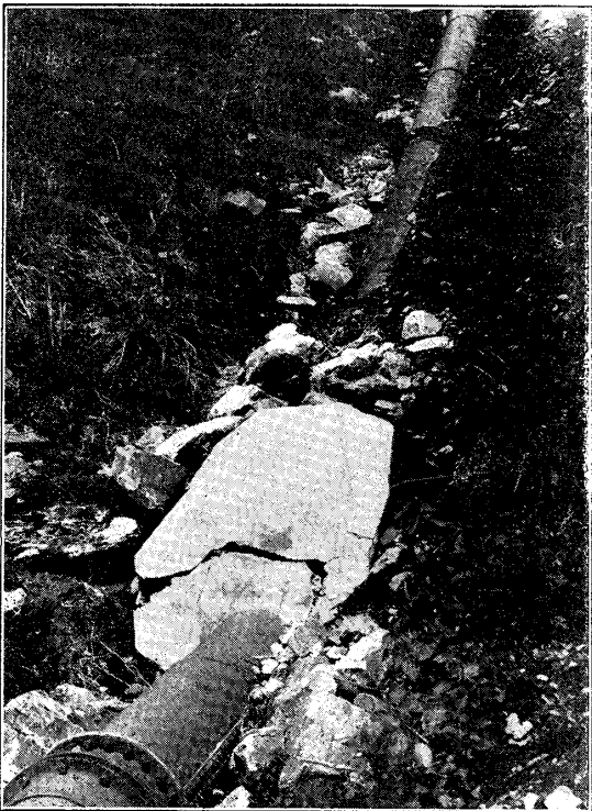
第六 箱根同會社畑宿發電所水壓鐵管「アンカーブロック」 ノ被害狀況
