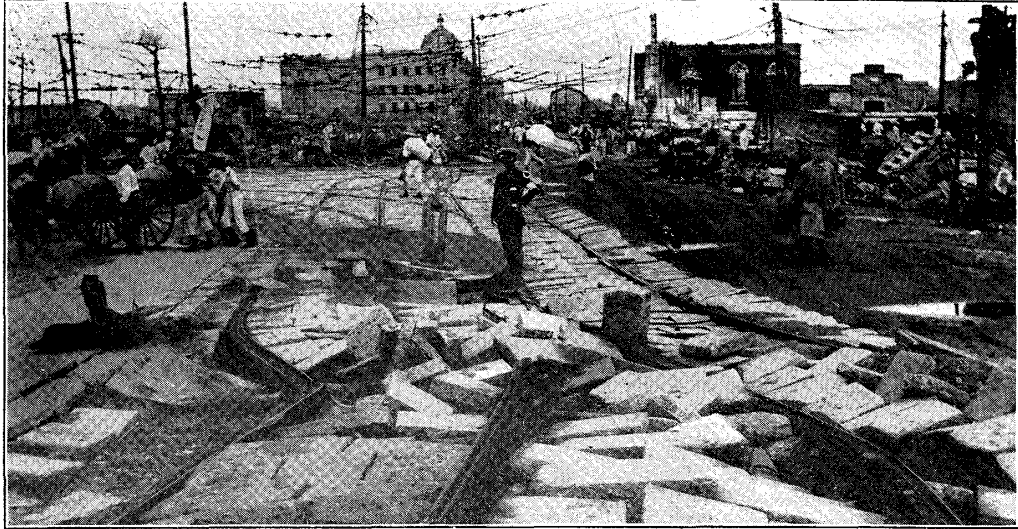
況狀害被ノ道軌及路線電ルケ於ニ點又交道車馬市濱横 四十三第
