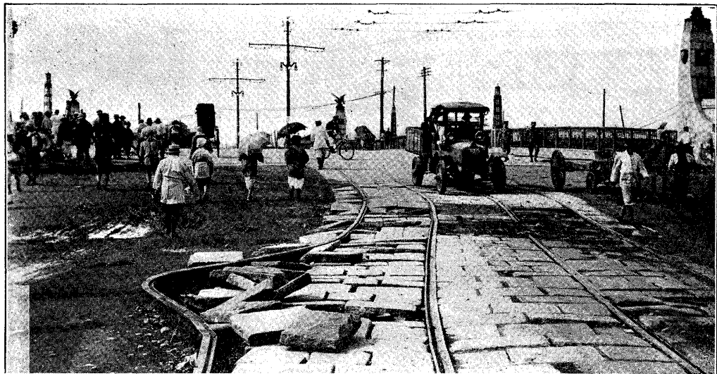
況狀ルセ曲彎メタノ災火震ガ條軌ノ後前橋江大市同 五十三第 鐵ハ脚橋及臺橋テシニ橋拱鋼ルタレラセ設架近最ハ梁橋本) (リナ微輕テメ極害被メタガルナ造土凝混筋)
