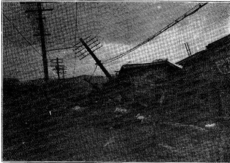
第二十六 小田原町内架空電線路ノ被害狀況 (電氣鐵道ノ被害)
