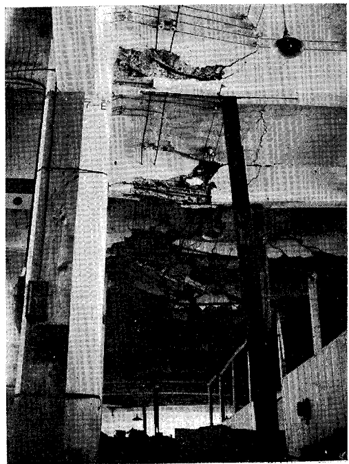
寫真第二 芝日本電氣工場
