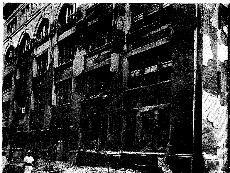
寫真第二〇 三越吳服店西側外面 日本橋區 火熱ニヨル貼付煉瓦ノ剝落
