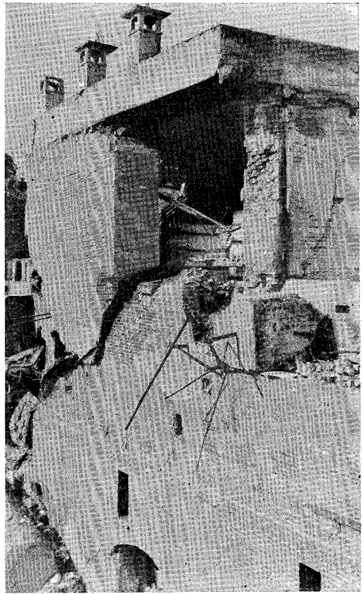
寫真第九 同上 二階建ノ被害
