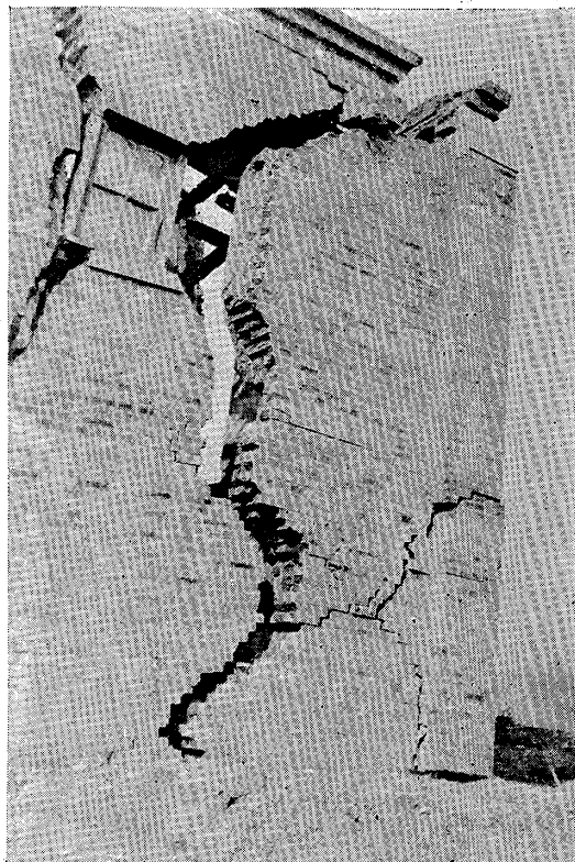
寫真第一九 山下町一七「シヤパン」製氷株式會社工場 煉瓦壁ノ龜裂
