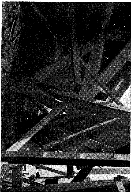
寫真第九四 同右側柱挫折ノ狀况方杖ノ下ニテ 挫折セリ
