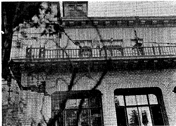
寫真第二一二 芝區白金臺町 藤山圖書館南側
