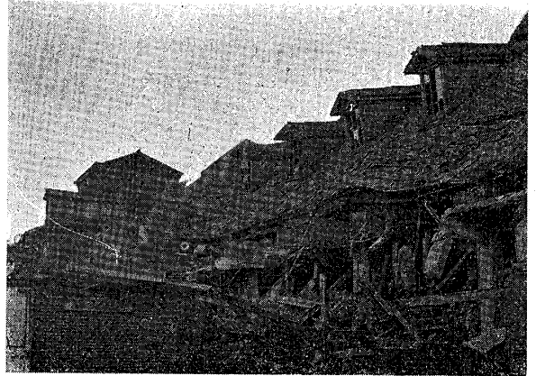
No. 262 寫眞第二六二 同上 工場ノ六
