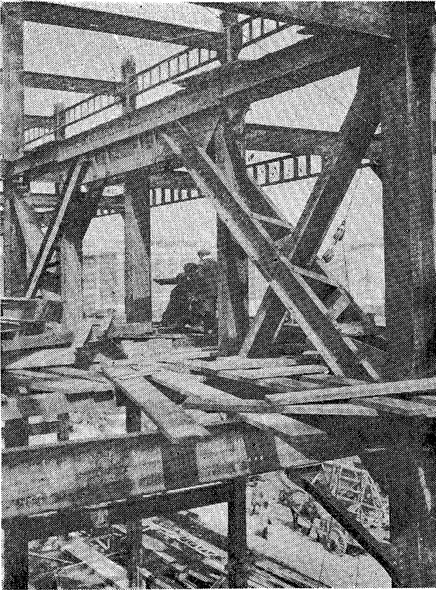
No. 14 寫真第一四 同上 (Trussed Girder)
