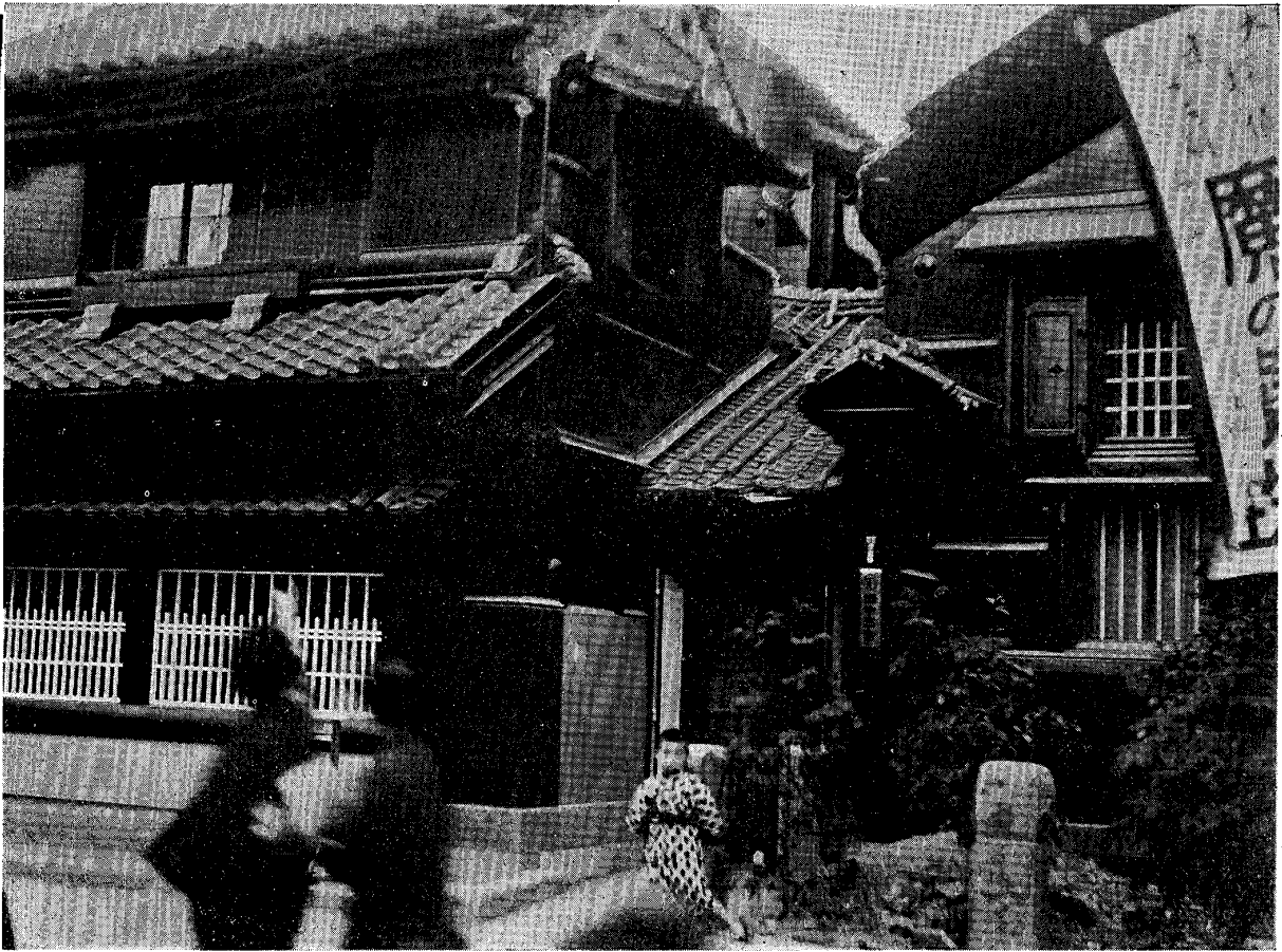
ス示ヲ況狀ノ落脱瓦及壁妻切造藏土方會商中田八十二町柳小區田神 リセ傷重名二ノモルタシ出ビ飛ニ外屋テシトシ難避リヨニ落脱該
