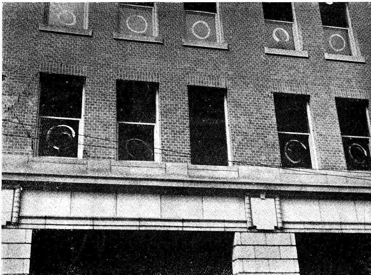
ス示ヲ裂罅ノ壁外側南グンデルビ内ノ丸
