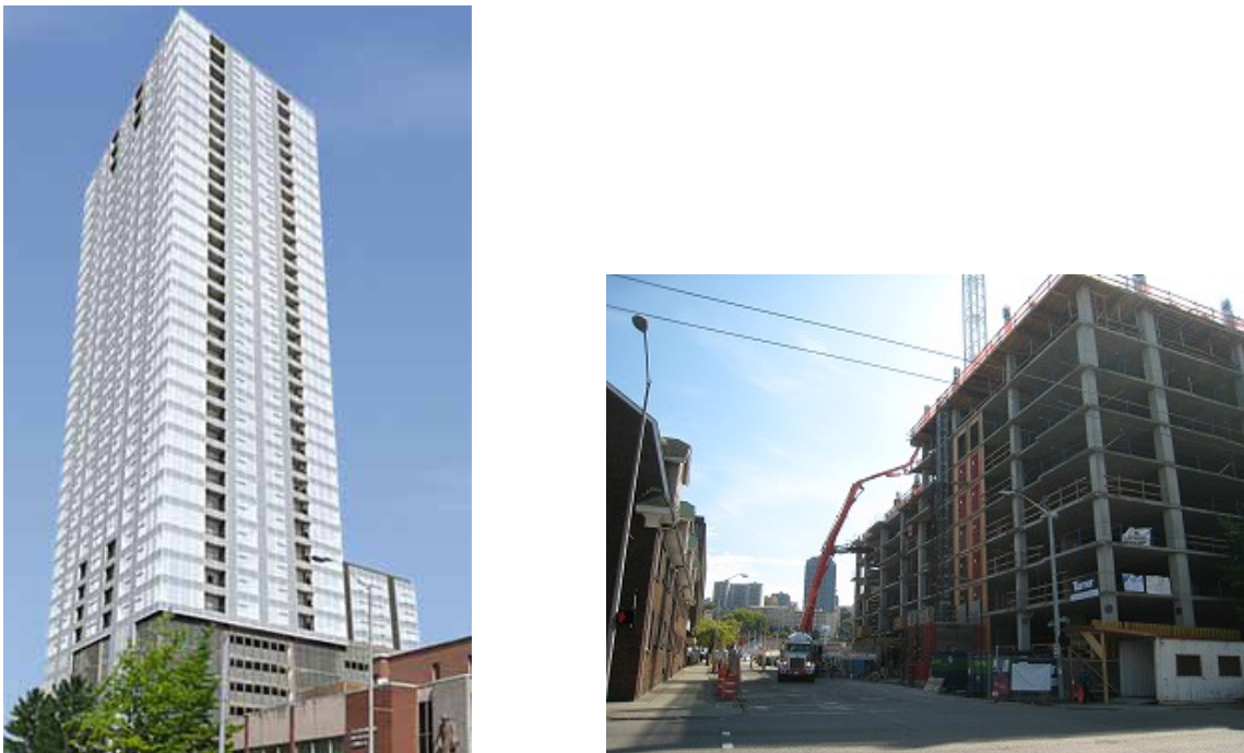
図8-1 2. (左)Aspira 完成予想図(郡提供資料より抜粋)、(右)建設中の Aspira (2008年9月筆者撮影)
