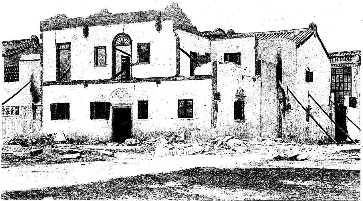
破大ノ屋家建階二造詰縮地街市新西北ノ街市頭油 圖二第 ス壞倒ク全部半前ノ方南テシニ尺一サ厚ノ壁
