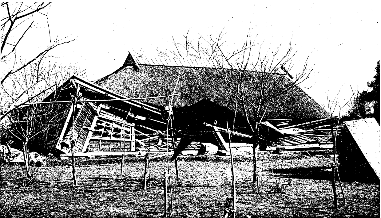
平屋ハ普通屋根際ニテ柱折ル、爲メ屋根チ潰ルモノトス
