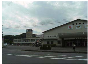
田村市体育館と中央公民館
