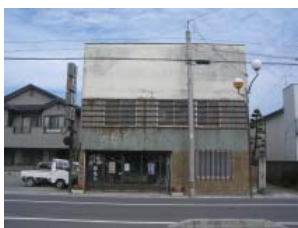
国道側ファサード
