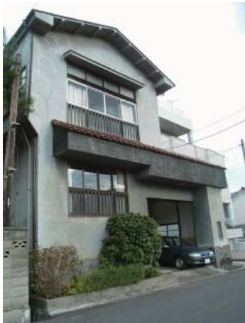
大滝根川側ファサード
