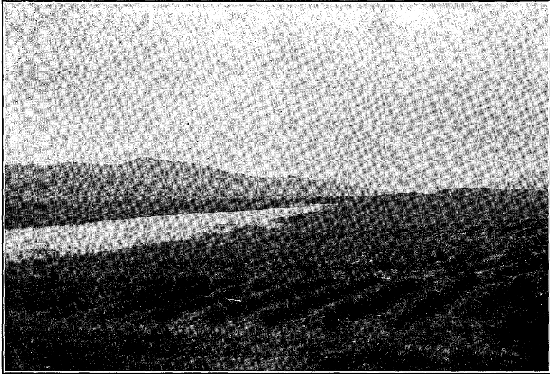
新居村上野町間街道上柘植川ノ左岸ヨリ震災當時ノ 陥没地ヲ望ム 圖ノ中央ヨリ左ニ連ナリ川ノ右岸ニ沿ヘル地域是レナリ
