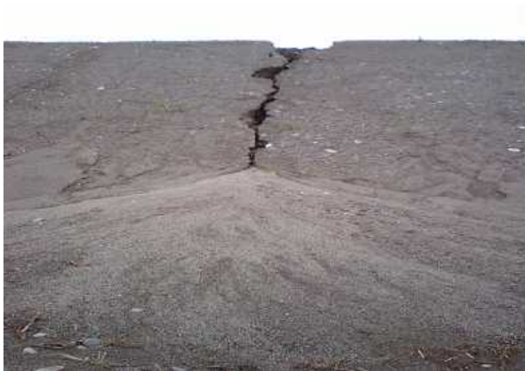
写真 8 : 右岸側の置き砂斜面雨溝浸食跡
