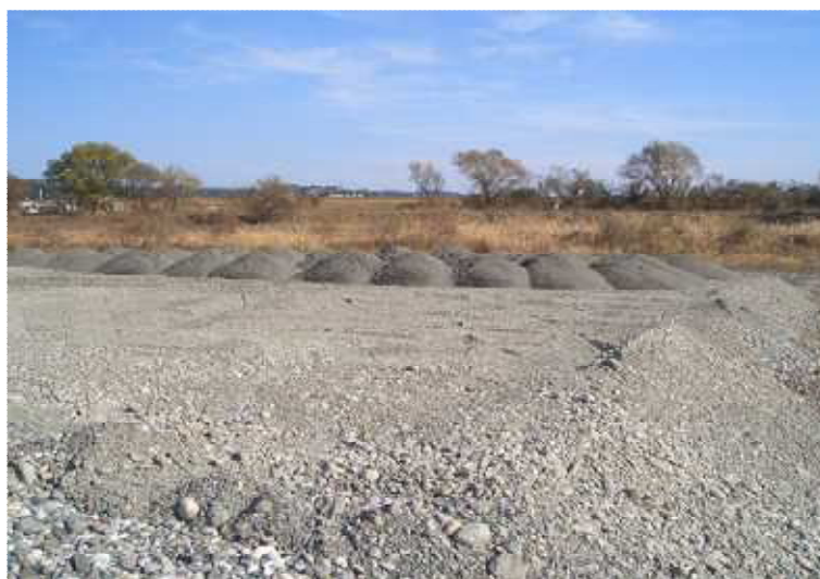
写真 9 : 左岸側の置き砂設置風景
