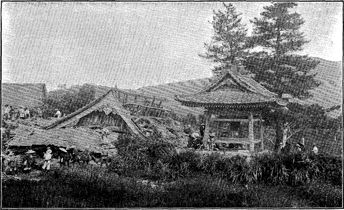
尊勝寺村稱名寺ノ鐘樓、柱上ニテ三尺移動ス
