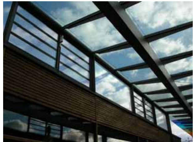
写真 4 : ガラスの屋根と側面のルーバー
