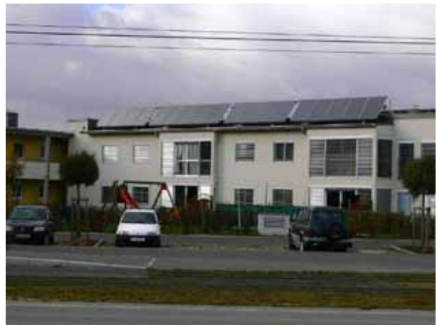
写真 4 : 屋根の上に並ぶ太陽光集熱パネル
