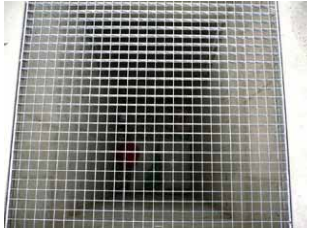
写真 6 : 地下倉庫のための採光口
