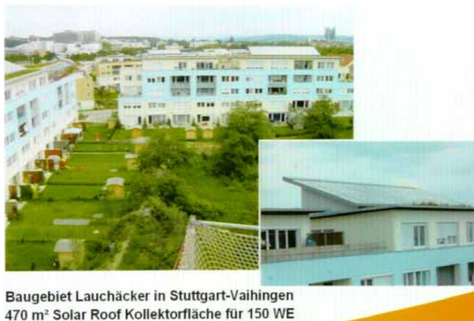
図 7 : Kollektor-“Pult” auf Flachdach
