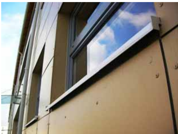
写真 3 : 窓の下には換気口
