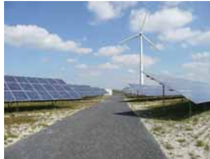
図 2-1-13：個人の PV 地面置き発電所 16
