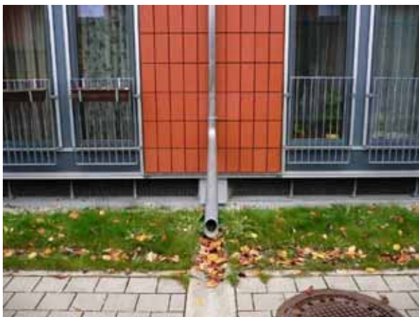
写真 3：床下換気口と雨水排水
