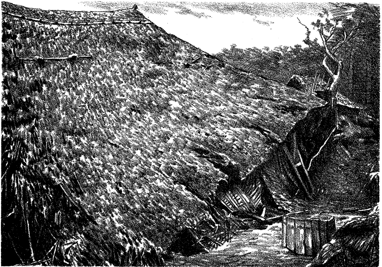
山形縣西田川郡黒森村 斷層ヲ生ジ地ノ陥落スルコト八尺ニ及ブ戸ノ住家此ノ斷層ニ當テリテ倒壊ス
