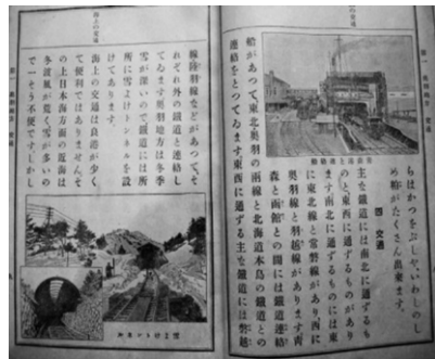
d 雪よけトンネル
