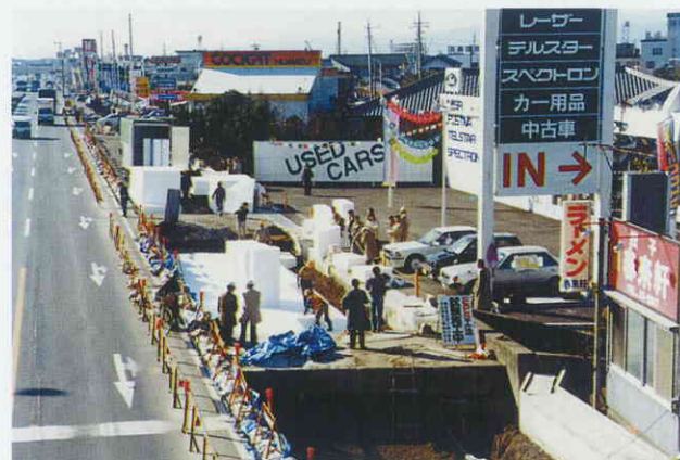
図4 EPS工法による道路拡幅工事
